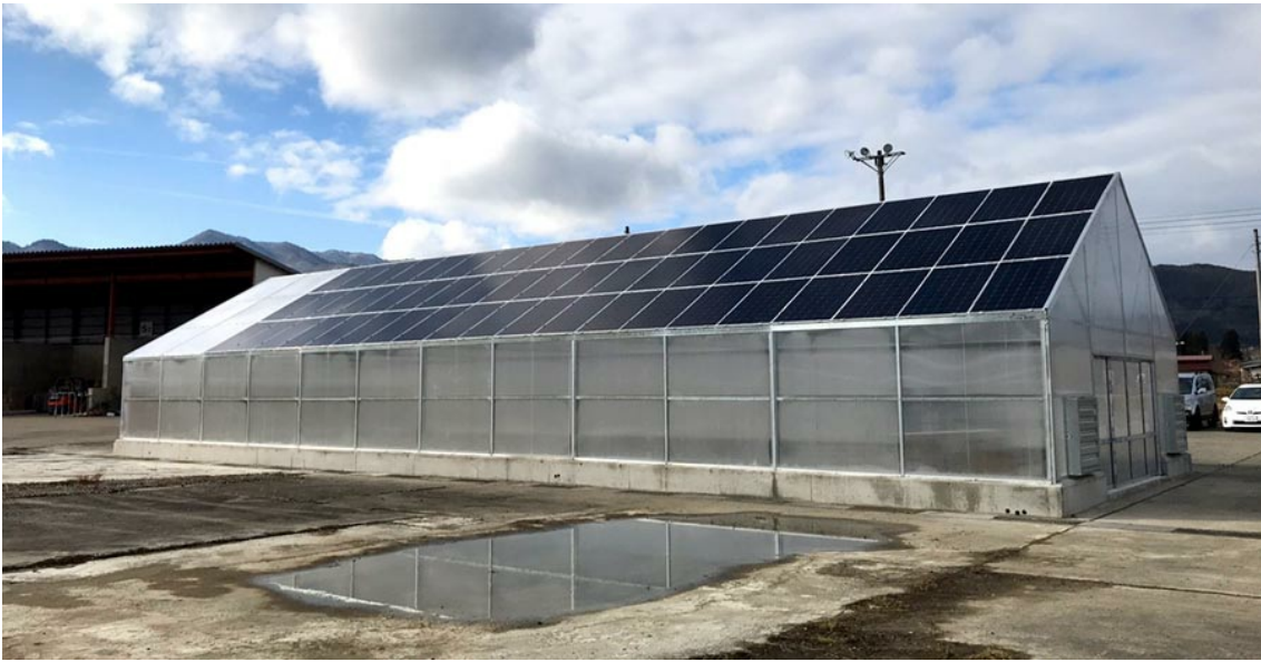
会津太陽光発電の「オフグリッド農業用ハウス」
